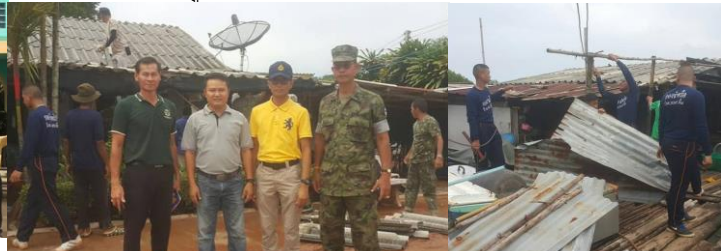
▲ วันที่ ๒๙ มิถุนายน ๒๕๖๒ เวลา ๐๔.๐๐ น. อบต.แหลมฉบังประสานขอกำลัง อส.และทหารเพื่อช่วยซ่อมแซมเปลี่ยนกระเบื้องหลังคาของบ้านเรือนที่ประสบวาตภัยหลังคาปลิว แตก นำทีมโดยปลัดยุทธนา สร้อยเสนา และรองปลัด อบต. ผู้ใหญ่ อนัน ร่วมดูแลการดำเนินการ ณ พื้นที่หมู่ ๕ แหลมทองกลาง
