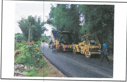
ปรับปรุงซ่อมแซมถนนสายบ้านแหลมมะขาม ม.3-4
