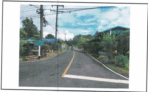
ปรับปรุงถนนสายบ้านแหลมทองกลาง ม.5
