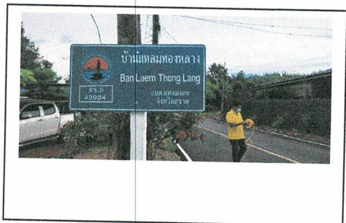
ปรับปรุงถนนสายบ้านแหลมทองกลาง ม.5
