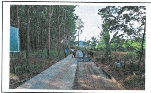
ก่อสร้างถนน คสล.สายบ่อหิน-เนินขี้ไหล ม.4
