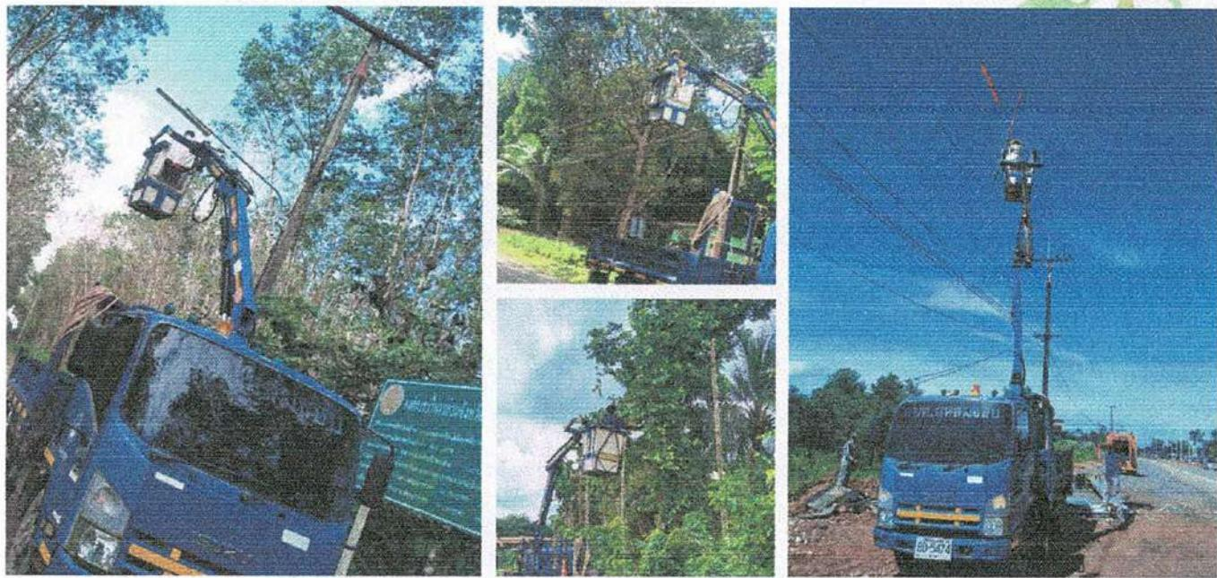
**ไฟส่องสว่าง -** นายช่างไฟฟ้า พร้อมทีมงาน ได้ออกดำเนินการซ่อมแซมไฟฟ้า ส่องสว่าง และเปลี่ยนโคมใหม่ทุกแทนโคมเก่าที่ชำรุดจนไม่สามารถซ่อมได้ รวมกว่า 20 จุด และยังได้ดำเนินการตรวจสอบดูและระบบสายไฟแรงต่ำในพื้นที่ โดยการตัดต้นไม้ และกิ่งไม้ที่ละสายไฟ เพื่อป้องกันสายไฟชำรุดและเหตุไฟชื้อต-ไฟไหม้ นอกจากนี้ ยังได้ออนุเคราะห์รถกระเช้าพร้อมคนขับเข้าร่วมกับ กฟภ.แหลมทอง ดำเนินการไส่การดครอบสายไฟแรงสูงและดูและระบบสายไฟในพื้นที่ตำบลแหลมทองและพื้นที่ใกล้เคียงร่วมกัน
